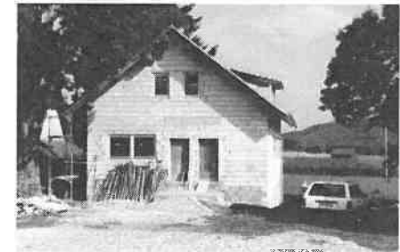
Der Rohbau steht
