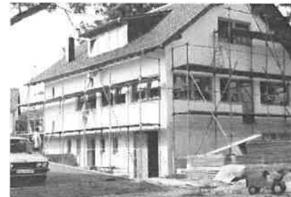
1992 - Kurz vor der Fertigstellung
