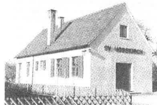
"Alte Molke" - 3. Umkleidestation
